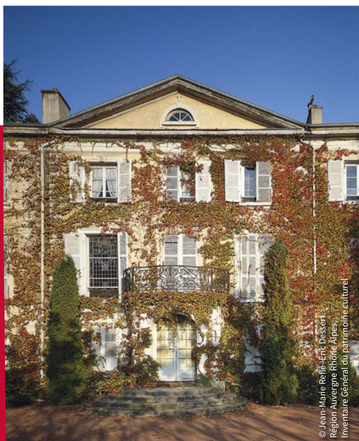
Façade du château des Balmes
