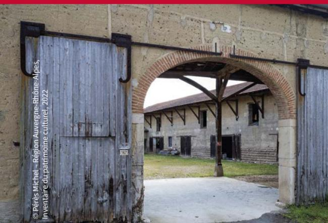
Ferme de Corcelles, Aile nord : entrée charretière avec arc surbaissé en briques de terre cuite et mécanisme de portes coulissantes
