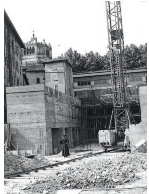
Construction de l'église semi-enterrée en 1959.
