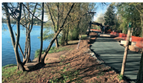
À Parcieux, fondation avant la pose du sablé.
