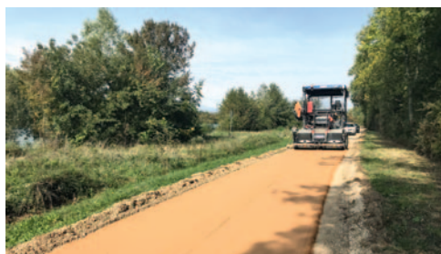
À Massieux, mise en place du sablé stabilisé.
