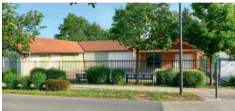
La salle communale rénovée à Toussieux.
