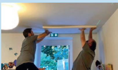
Installation des panneaux acoustiques à la micro-crèche à Parcieux.
