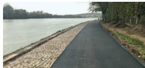
Entre Trévoux et Reyrieux, rénovation du chemin historique en galet et enrobé sur le côté.
