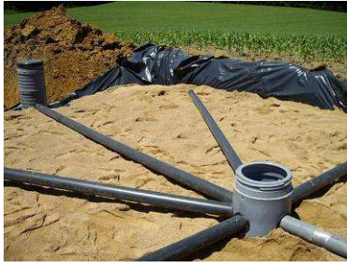
Filtre refusé car les tuyaux d'épandage ne sont pas posés sur une couche de graviers
