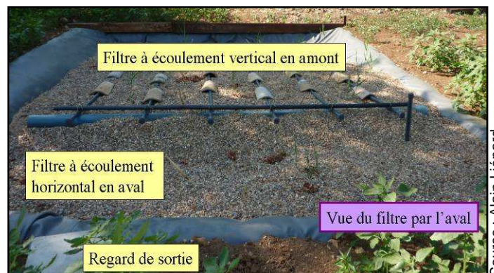
Filtre planté avant recouvrement par une couche de compost d'environ 10 cm
