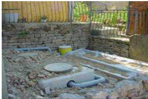
Exemple d'installation sur une surface réduite (Jura)
