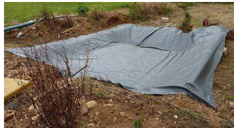
Mise en place du feutre anti-poinçonnement Mise en place de la géomembrane
