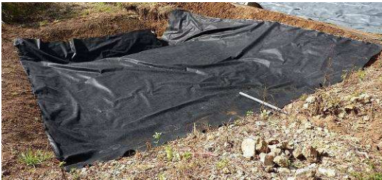
Mise en place du feutre anti-poinçonnement Mise en place de la géomembrane
