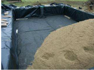
Filtre refusé car les tuyaux d'épandage ne sont pas posés sur une couche de graviers
