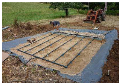
Mise en place et calage du réseau de distribution sur le filtre vertical
