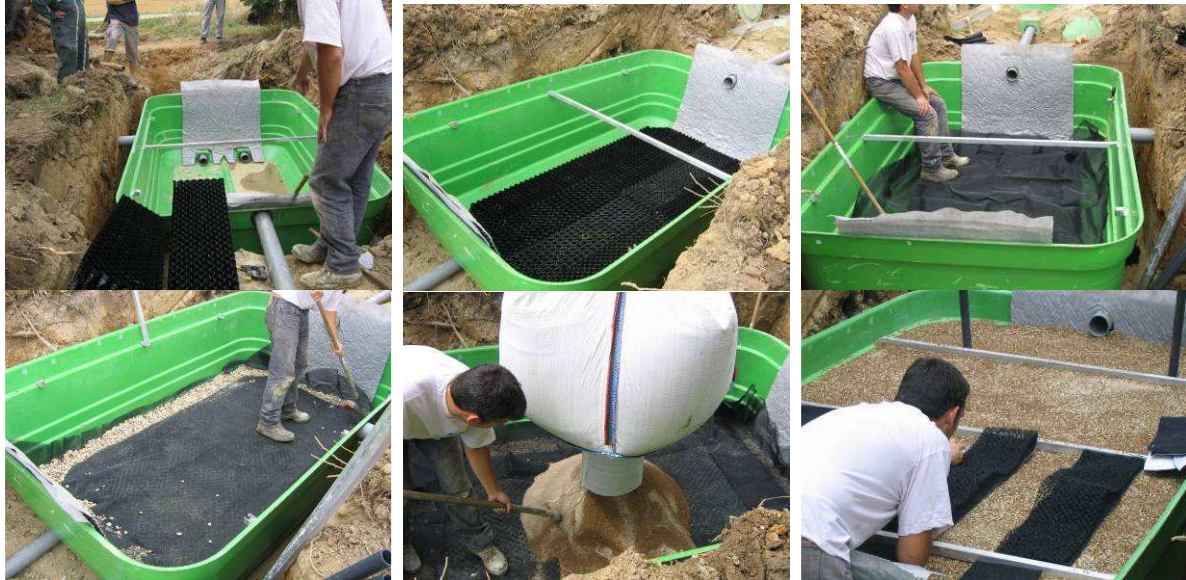
Mise en place d'un filtre à zéolite 1 (Ain)
