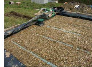
Filtre refusé car les tuyaux d'épandage ne sont pas posés sur une couche de graviers
