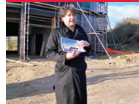
VISITE DE CHANTIER « LE GALET »
