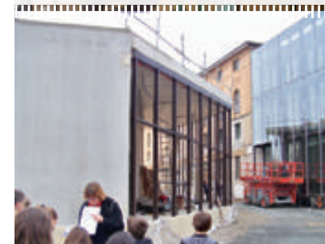
VISITE DE CHANTIER - ESPACE CULTUREL
