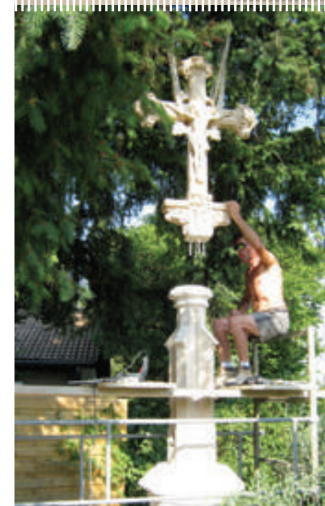
CROIX DE PARCIEUX EN COURS DE RESTAURATION
