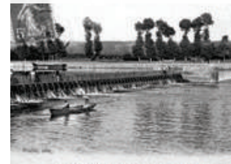
A PARCIEUX (AIN) - Barrage de Port Bernalin
